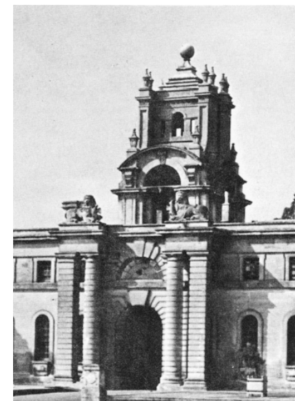
59. Vanbrugh. Palatul Bleinheim, Oxfordshire
